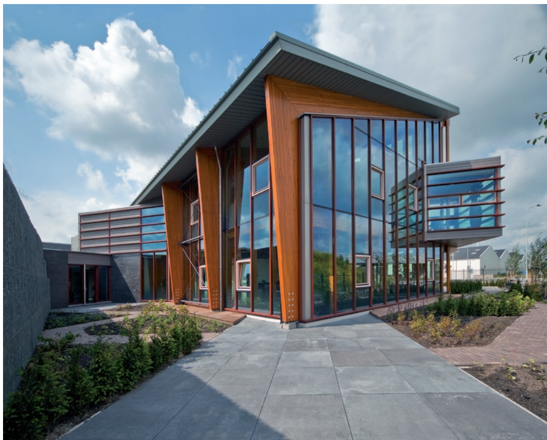
De knikspanten halen een hoogte van 12 m. Het gebouw heeft aan beide zijden een uitstulping, hier het directiekantoor (rechts).
